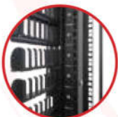
Thanh bắt thiết bị có khóa ID và được đánh số U rõ ràng
