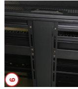
Thanh bất thiết bị có khóa ID và được đánh số U rõ ràng
